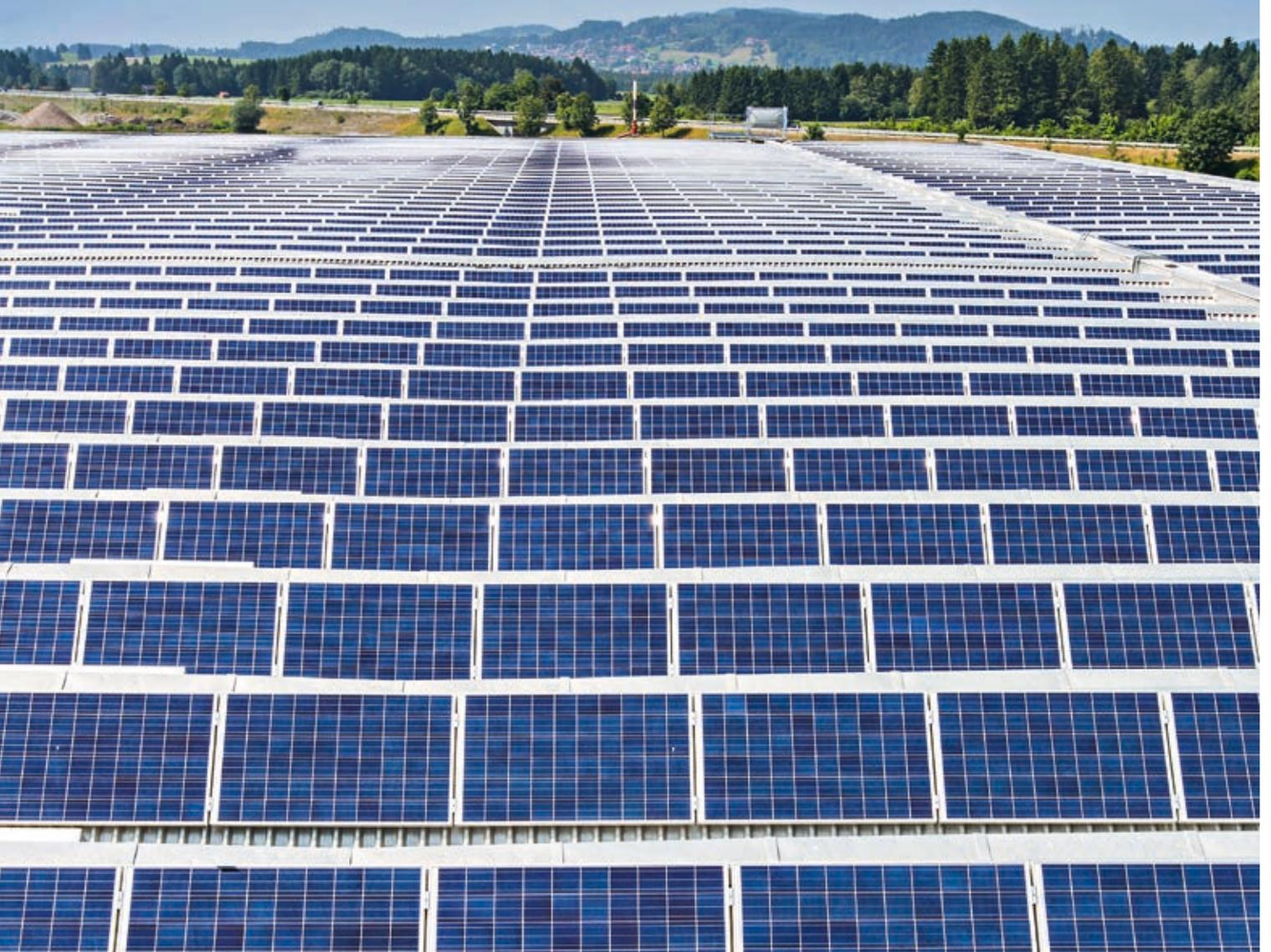
Otto Bihler Maschinenfabrik utiliza la energía fotovoltaica para cubrir alrededor del 75 % de sus necesidades de electricidad en su sede de Füssen. En el mismo orden de magnitud está el sistema fotovoltaico que pronto entrará en funcionamiento en la instalación de Halblech.
